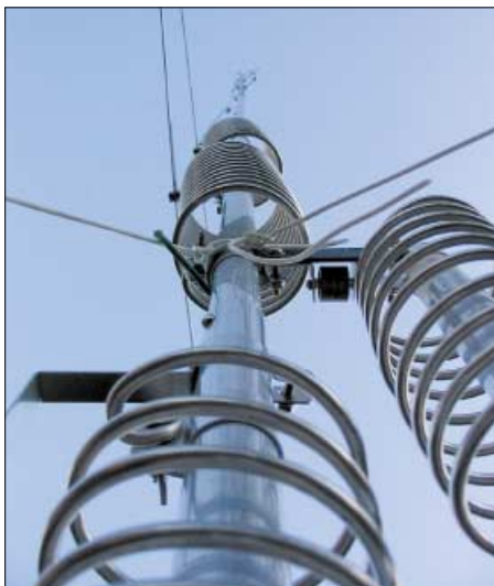
Bild 7: Gesamtansicht der HF9V von unten
